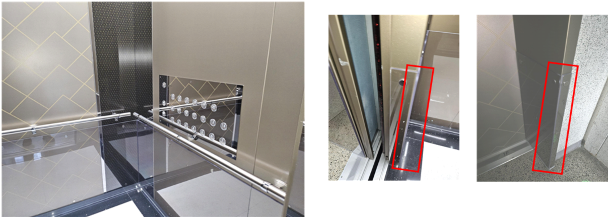
[그림2] 카 내부 보호 커버 ( 폴리카보네이트 T3. 카 출입구 및 삼방틀 양쪽 연결부 일체 형)
