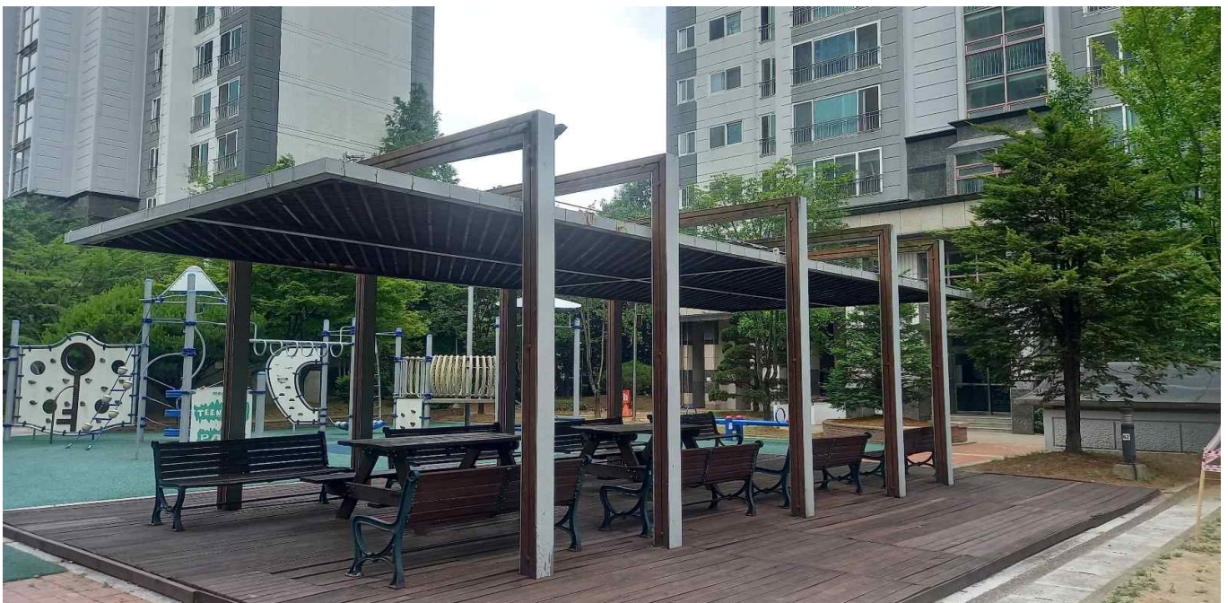
951동 앞 놀이시설 옆 휴게시설 기존데크 현장사진
